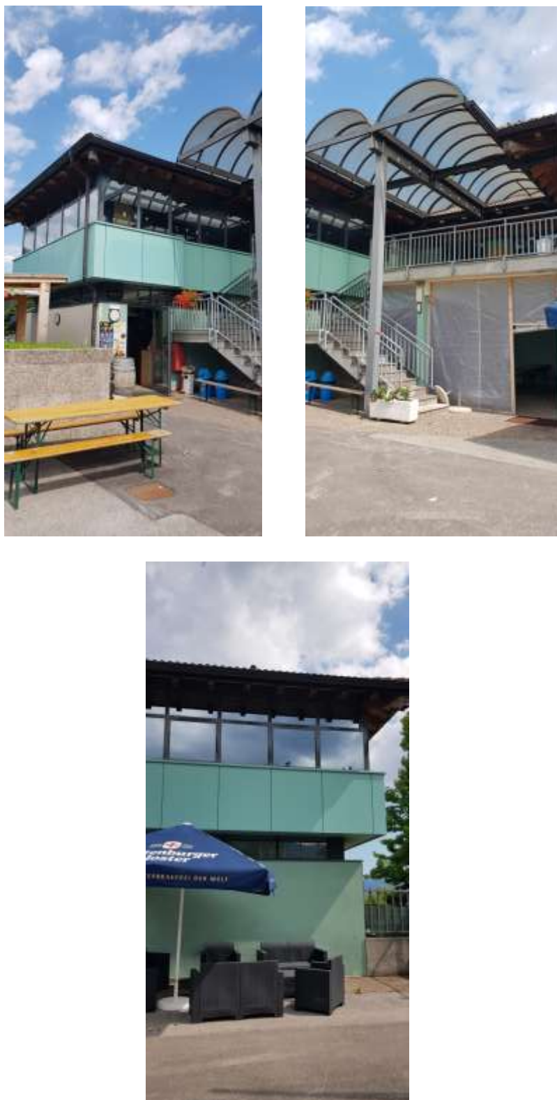
Figura 13- foto della palazzina servizi
