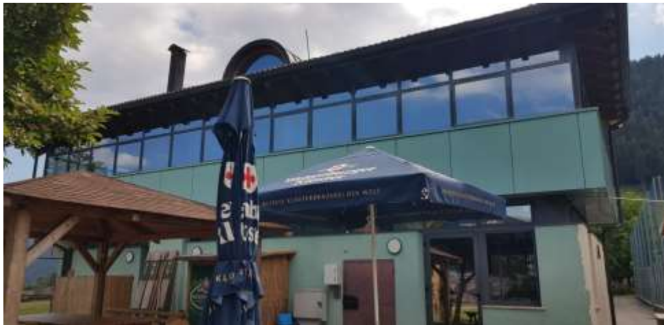
Figura 12- foto della palazzina servizi
